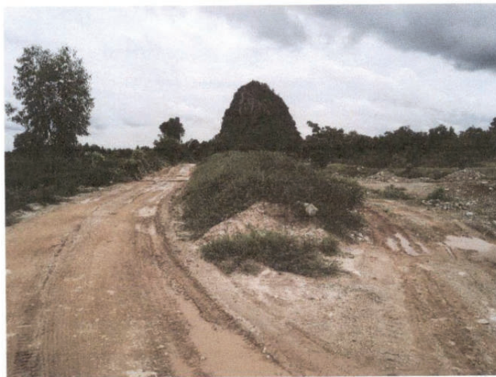
รูปที่ 5 แสดงคันทำนบกั้น โดยที่ใช้เศษหินและดินปรับแต่งเป็นแนวคันทำนบกั้น บริเวณด้านตะวันออกทางเข้าโครงการฯ
